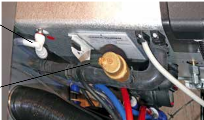
Bild över värmepanna i soffbänken, förarsidan
