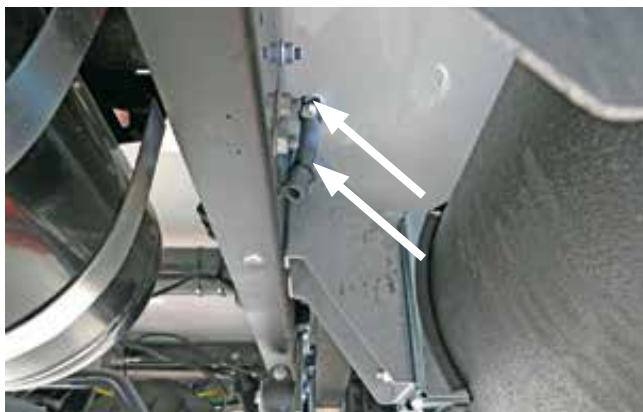
Spillrör, ventilation vatten-/avloppstank, under chassit, förarsidan
