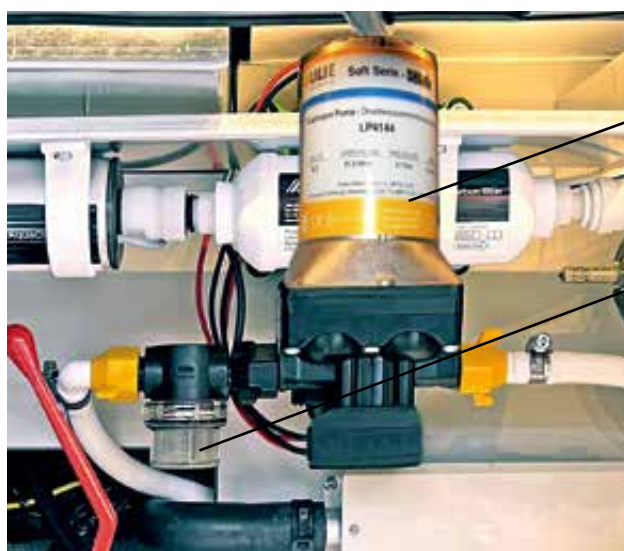
Vattenfiltret och filterdosan bildar en enhet
