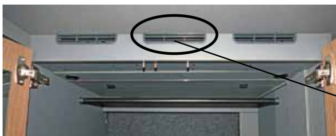
Inspektionsöppning centrallås garderobsdörrar, dörr ovanför kylskåp
