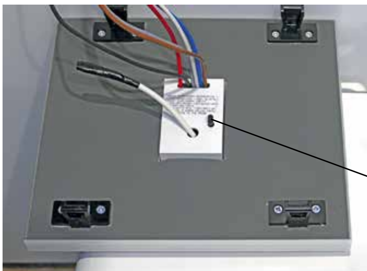
Justerskruv vattenflöde toalettspolning
