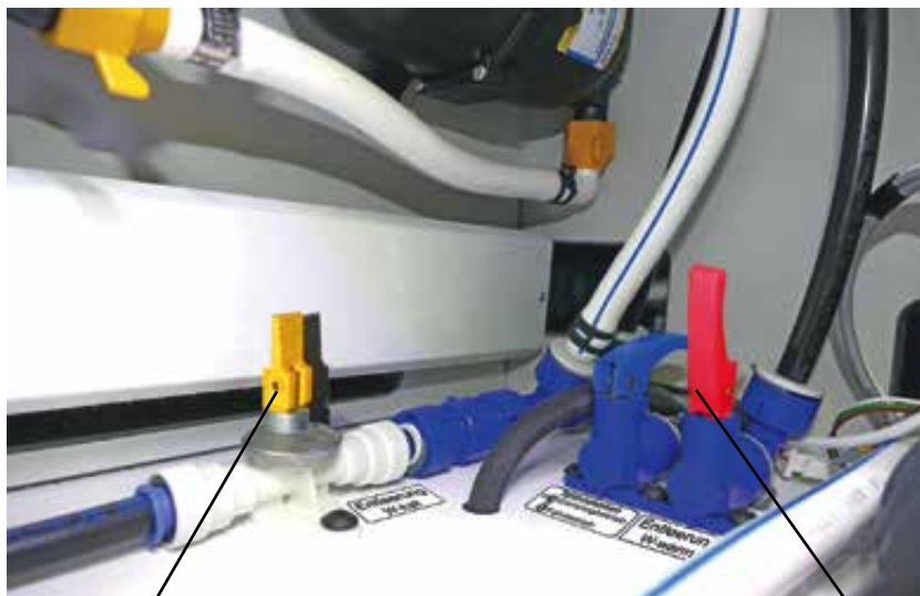
Tömningsventil ledningssystem varmvatten öppen
