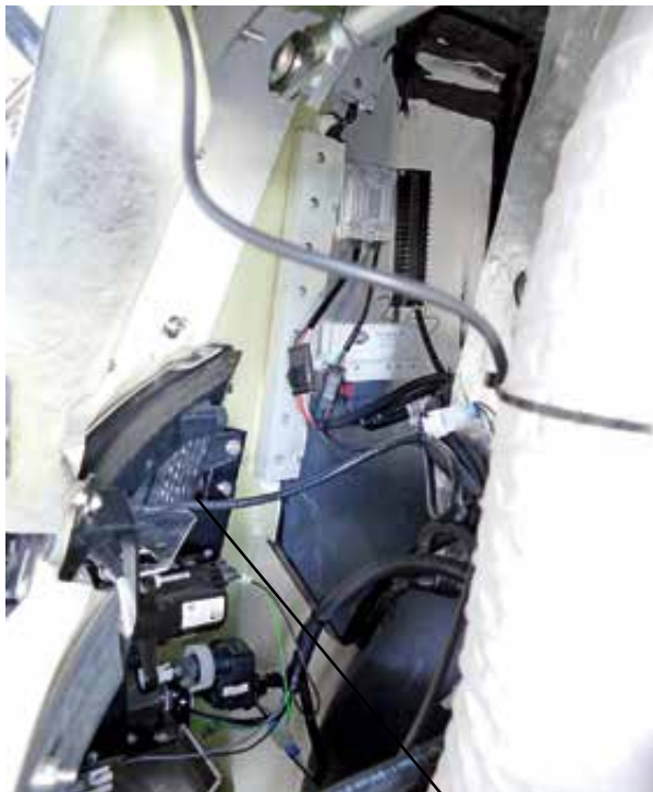
Montera plåt med strålkastare
