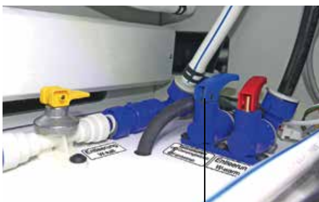
Ventiler i anslutningsfacket
