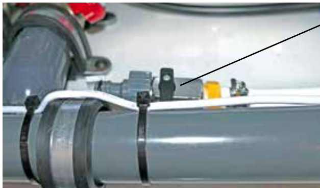
Spolanslutning tanksond latrintank (tillval) i anslutningsfacket
