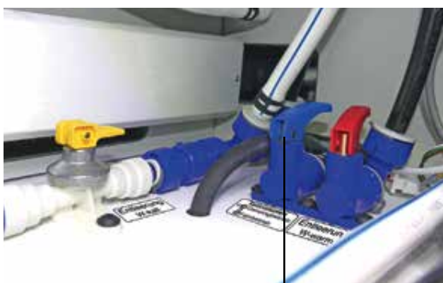
Venttiilit huoltotilassa Koko kylmä- ja lämminvesiputkiston ja boilerin tyhjentäminen. Kylmävesiventtiili on samalla ylipaineturventiili
