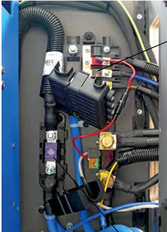
Esimerkki, 70 A Midi-ruuvisu-lake pääsulakeblokissa B2
