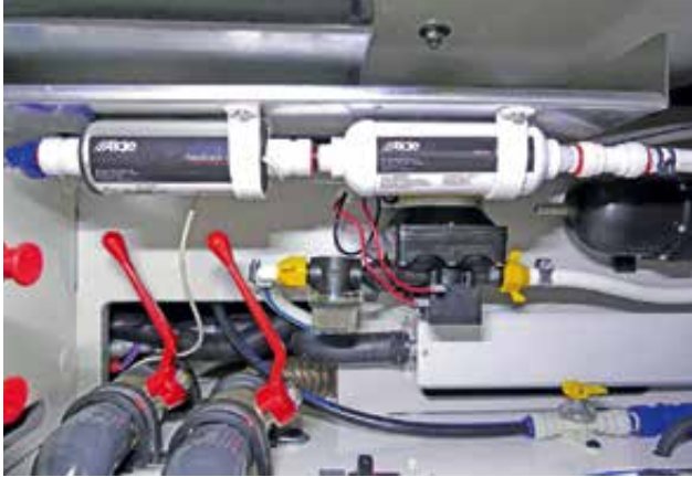
Vesipumppu ja vesi-suodatin sekä UV-hiili-suodatin huoltotilassa (lisävaruste)
