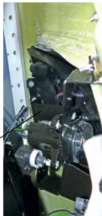
Montera plåt med strålkastare
