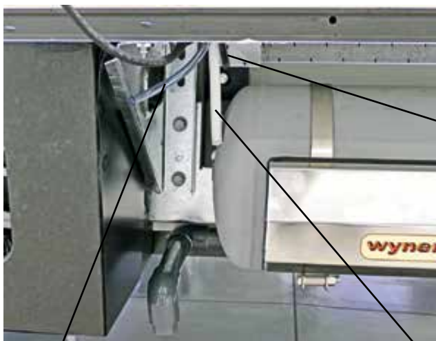
Slangstuts, bakslagsventil värmepanna, vattenburen värme under värmepannan
