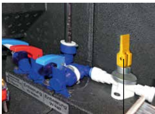
Spak uppåt = säkerhets-/avtappingsventilen öppnats
