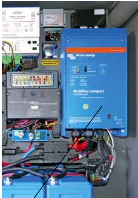
Tillval växelriktare victron energy MultiPlus Compact 12V/1600W/70A
