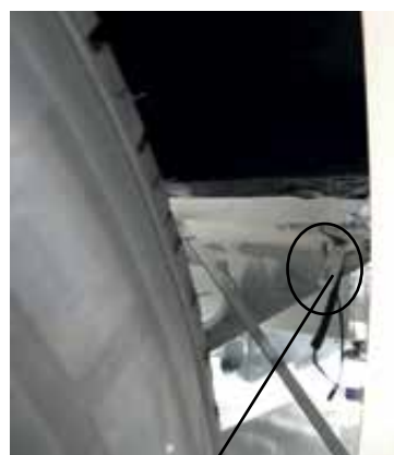
Slangstuts kondensvattenavrinning, låd kylskåp
