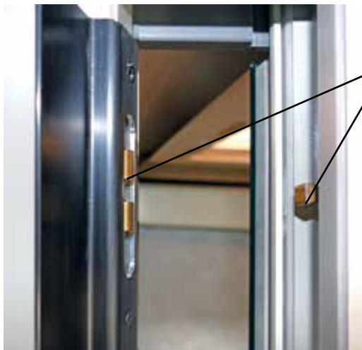
Kulsnäpplås vid trappstegsluckor och sluten förvaring
