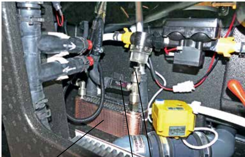
Värmeväxlare i anslutningsfacket
