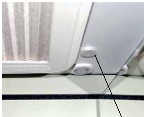
Rörelsedetektor i badrumstaket
