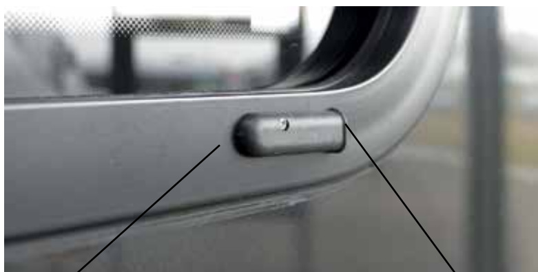
Fönsterkarm, skjutfönster förarhytt, utvändig
